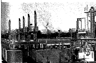
Centrale Bioelettrica di Inzago (MI)
